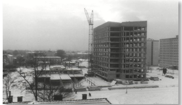
Budowa Wydziału Leśnego (15.12.1978, Fot. 306/69)
